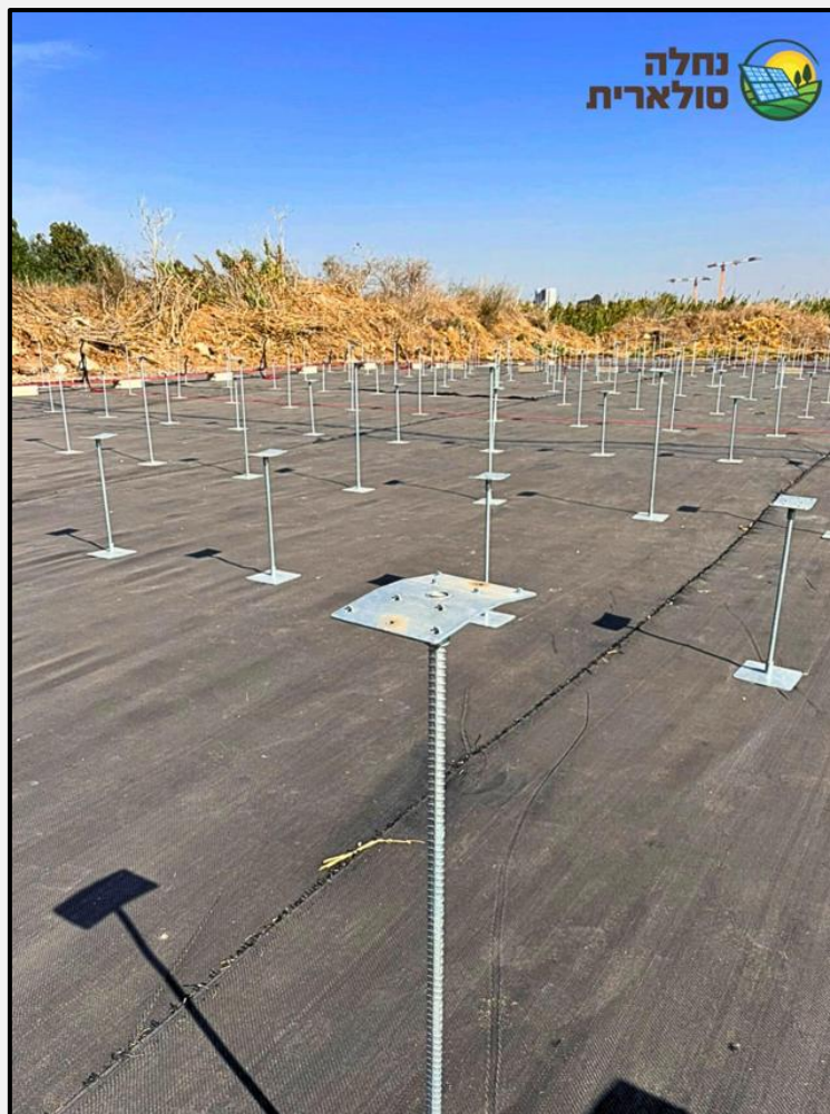
תמונה 6: אופן התקנת מתקן PEG
